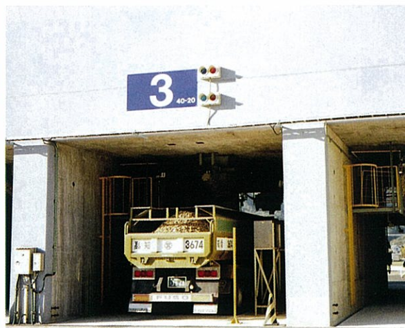
写真 1-12 トラックによる出荷
